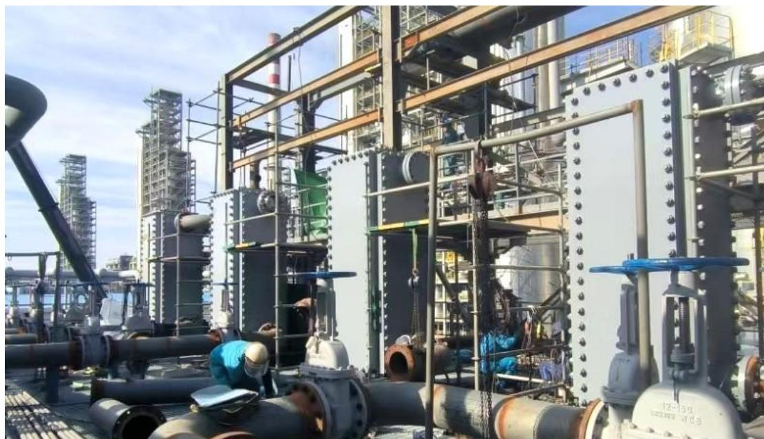
连续重整装置是大型炼化企业提高轻质油品质量和产量的关键装置之一，其液化气分离单元脱异丁烷的塔顶冷凝器产品素有石化领域换热设备的“皇冠”之称，长期被外资厂家垄断且生产交货周期长。该设备除需满足苛刻的换热能力和制造工艺的要求外，还需要在仅有的空间内兼顾能力提升和结构紧凑的现场安装。经过前期多次的技术交流和方案探讨后，充分考虑到换热介质异丁烷易燃易爆性，确认艾克森的全焊接板式换热器可以应对此挑战。项目最终选用了 4 台 A-BLOC 四面可拆全焊换热器，该设备兼具换热效率高、结
