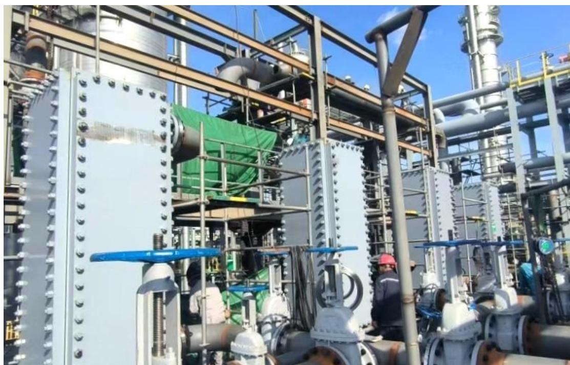
A-BLOC 四面可拆全焊接板式换热器在盛虹炼化连续重整装置的成功应用，彻底打破该装置塔顶冷凝器产品的国外垄断格局，标志着艾克森自主研发高端换热设备在石化炼油领域应用的新阶段，为推动石油炼化国产化进程迈出关键一步，也为石化领域的客户提供了更多值得信赖的选择。
