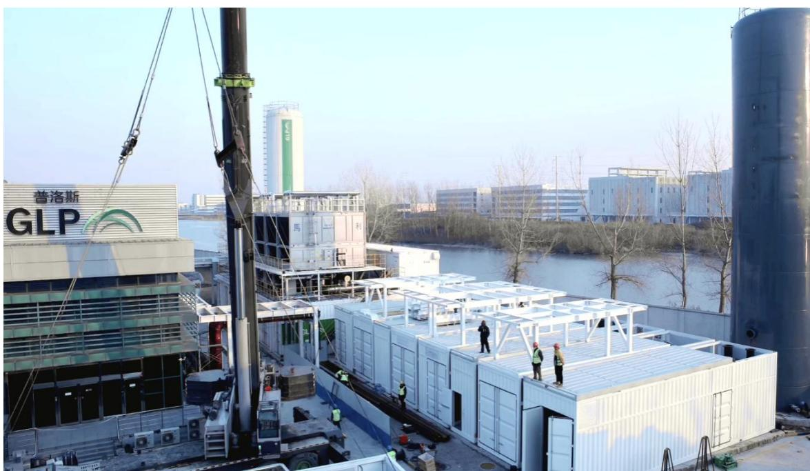
三期项目将单机冷量从 1300RT 提升至 2200RT，创下了目前国内外最大规模的预制集成冷站纪录。预制化集成冷站在工厂进行预装和调试，解体后运至现场进行拼装组合，在 20 小时内集装箱吊装拼接就位，冷却塔仅需简单吊装就位以及管路连接。就位后半个月即可完成内部管道、桥架、电缆等施工连接，具备通水通电条件，节省了大量现场施工时间，较一二期的室内预制化解决方案相比，吊装时间优化至 16 小时，整体项目交付周期缩短 30% 以上。以预制化建设、智能运维与超低 PUE 的卓越实践，为数据中心行业呈现了高效与节能并重的行业新范式。它不仅是一次技术集成的成功示范，更是对未来数据中心“快速交付、绿色运营”模式的有力回应。
