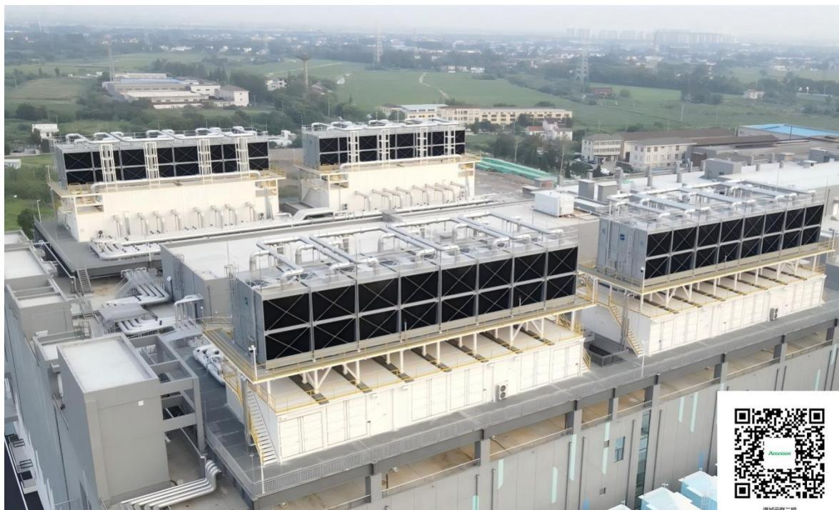
项目以“大规模、高可靠、高能效、100%绿色、风液兼容、预制集成、可再生水”为核心，按照 GB 50174-A 级标准设计，应用了风液同源双冷源风墙和 2N 的供电系统，弹性兼容 50-85% 风液冷比，占比高达 85% 的液冷能在大面积提升功率密度的同时，确保高功率芯片在稳定运行状态下的高效散热，有效应对业务增长的波动性，避免过度配置带来的资源浪费。通过构建“购绿电+自发电+储能”三级绿色能源体系，实现 2030 年数据中心全绿电 100% 覆盖运营。IT 负载率在 40% 情况下，夏季热月情况下运营 PUE 在稳定在 1.24-1.25 (6-9 月，华东常态气温 30-40°C 之间)，全年运营 PUE 约 1.2。构建了多级水资源循环利用系统，主体水
