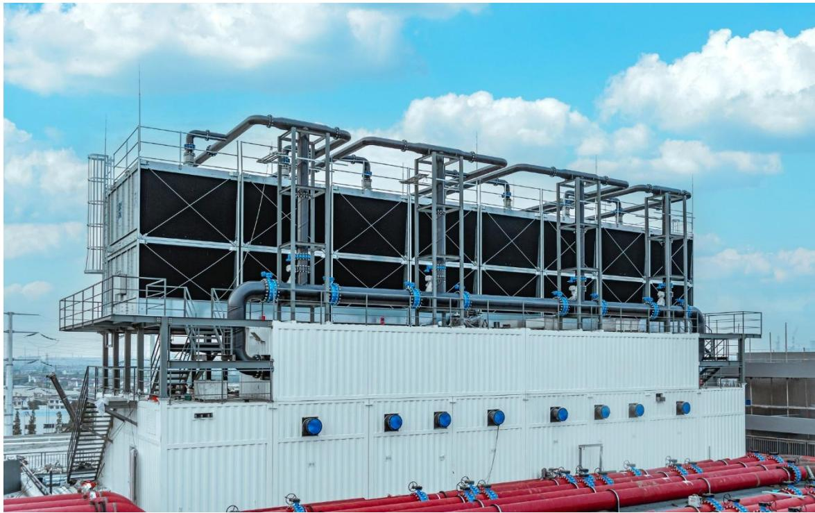
通过平面布局的弹性设计，将风冷、液冷部分公用一套冷却水系统，冷却塔、集成冷站集中设置于屋面框架梁上，利用建筑内空间和室外平台乃至屋顶平台空间的转换，可以让 40000 m<sup>3</sup>的建筑单体达 50-60MW 的设计容量弹性规划布局。在屋面供回水管路成环并在垂直立管到对应机房末端空调区，除提高了制冷系统的运行效率，同时解决了楼层机房公共区域综合管线设置的压力，提高机房垂直空间的利用，为机房极致利用起到了很好的示范作用。
