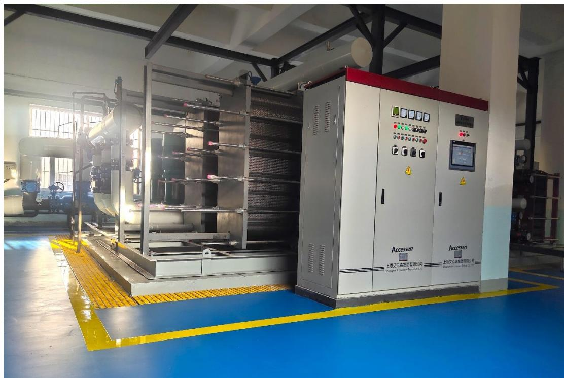
将原有换热站设备升级为成套的换热机组,不仅实现了结构紧凑外形美观的效果,还增加了温度、压力和流量、热量等数据采集,以及站房的视频和通讯等功能,使得更新后换热
